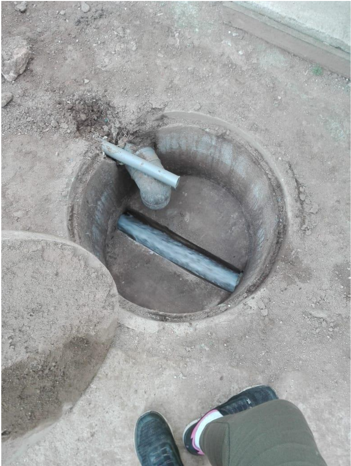
Figura 2-3: Última cámara domiciliaria de una comunidad de desagüe.
