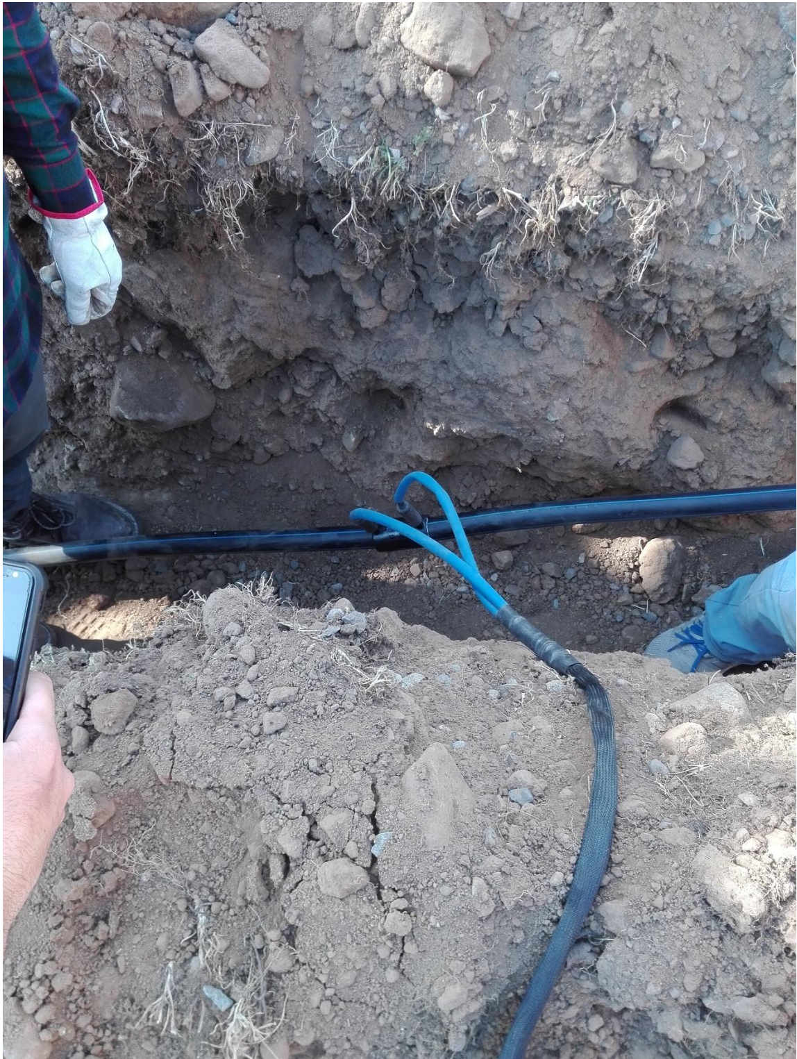
Figura 2-18: Soldadura por electrofusión.
