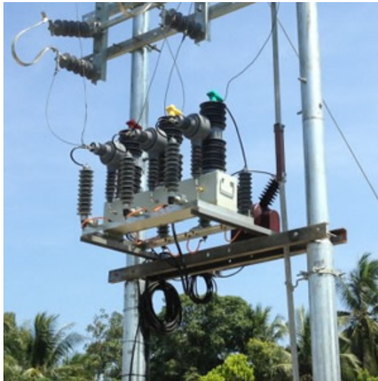
Figura 3.3: Controles de reenganche montados en poste.
