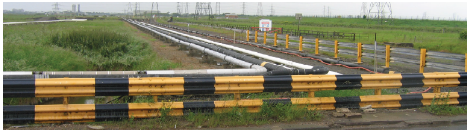
Figura 4.13: Ejemplo de barrera de seguridad de acero a lo largo de una carretera [40].
