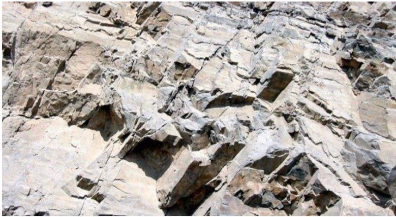
Figura 3.2: Discontinuidades macizo rocoso.
