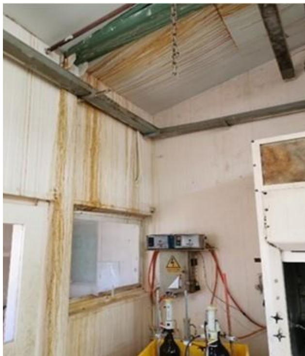
Figura 1-10. Estado de fachadas interiores afectadas por las inclemencias del tiempo
