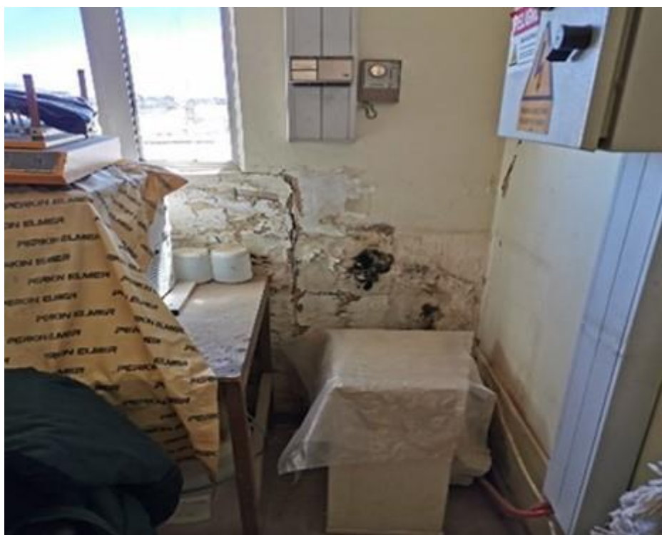
Figura 1-9. Muro interior afectado por la humedad
