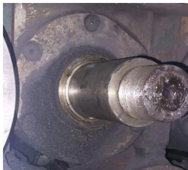
Figura 3 - 3. Presencia de laminilla metálica en tapa de lubricación de rodamiento.
