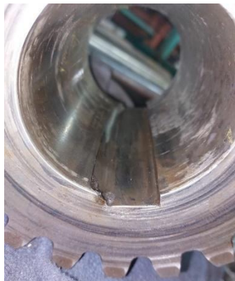
Figura 3 - 8. Desgaste en el interior del engranaje.
