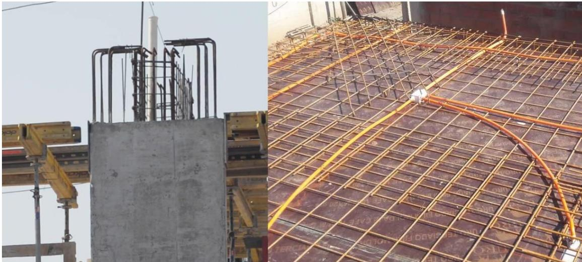
*Figura 3.1* Uso de barras seleccionadas en construcción nacional. A la izquierda el uso de barras CAP en una columna, a la derecha el uso de mallas ACMA en una losa, obtenidas de [www.capacero.cl](http://www.capacero.cl) y [www.acma.cl](http://www.acma.cl)
