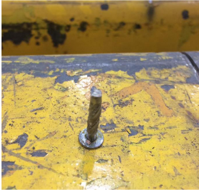
Figura 3-24, Clavo perteneciente al patrón de clavado perimetral luego del ensayo monotónico, donde se aprecia su modo de falla
