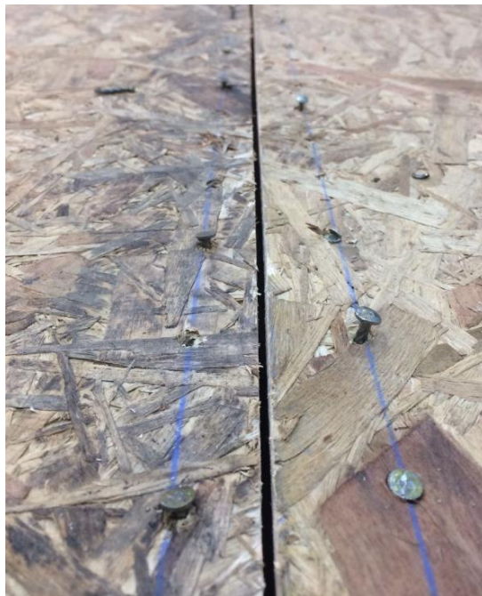
Figura 3-25, Patrón de clavado perimetral luego del ensayo, donde se puede apreciar como los clavos se rompen y expulsan del muro pero el OSB queda prácticamente intacto
