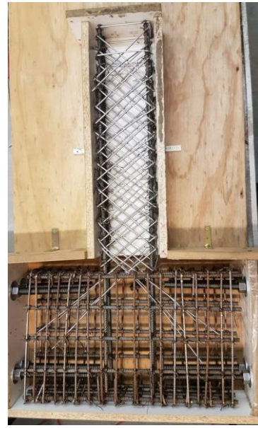
Figura 32: Moldaje con refuerzo y desmoldante aplicado
