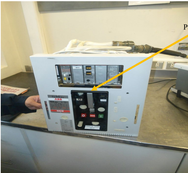
Figura 3-4 Breaker indicando palanca mecánica.
