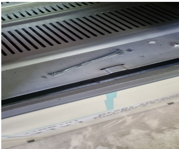
Figura 3-3 parte desprendida del breaker.
