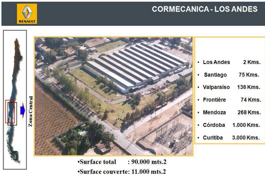
Ilustración 3.1.- Vista superior Cormecanica S.A. (1)
