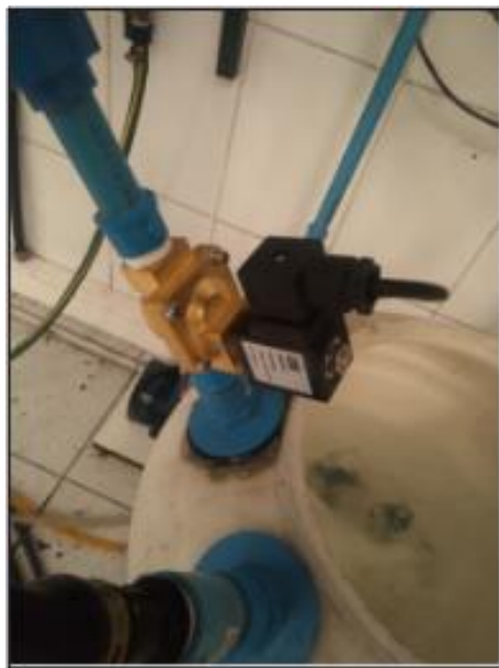
Figura B.2 Válvula solenoide de TK-103.
