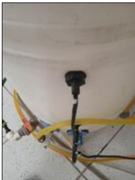
Figura B.3 Alarmas de nivel de TK-103.
