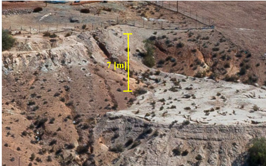
Ilustración 19. Desnivel de terreno en la zona 1 del Relave Indexy 1. Elaboración propia con Google Maps.
