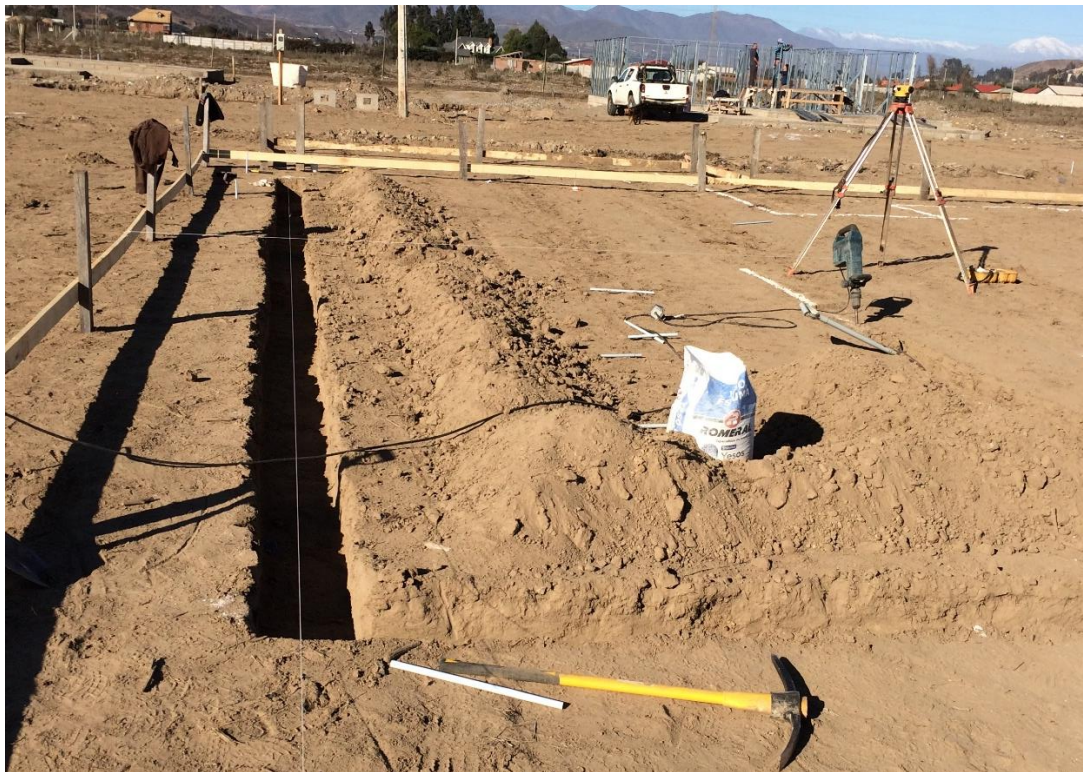
Fuente: Obra parcela 13 Los Alfalfares, La Serena Chile Figura 2- 6 Excavación
