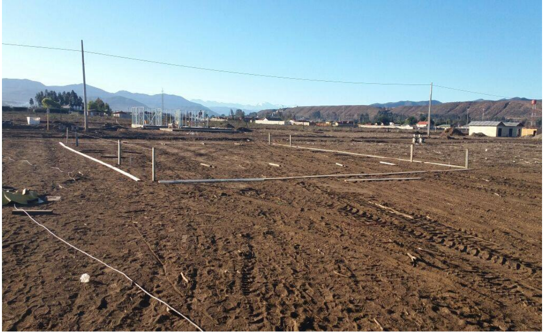
Fuente: Obra parcela 13 Los Alfalfares, La Serena Chile Figura 2- 5 Instalación corral de niveles replanteo
