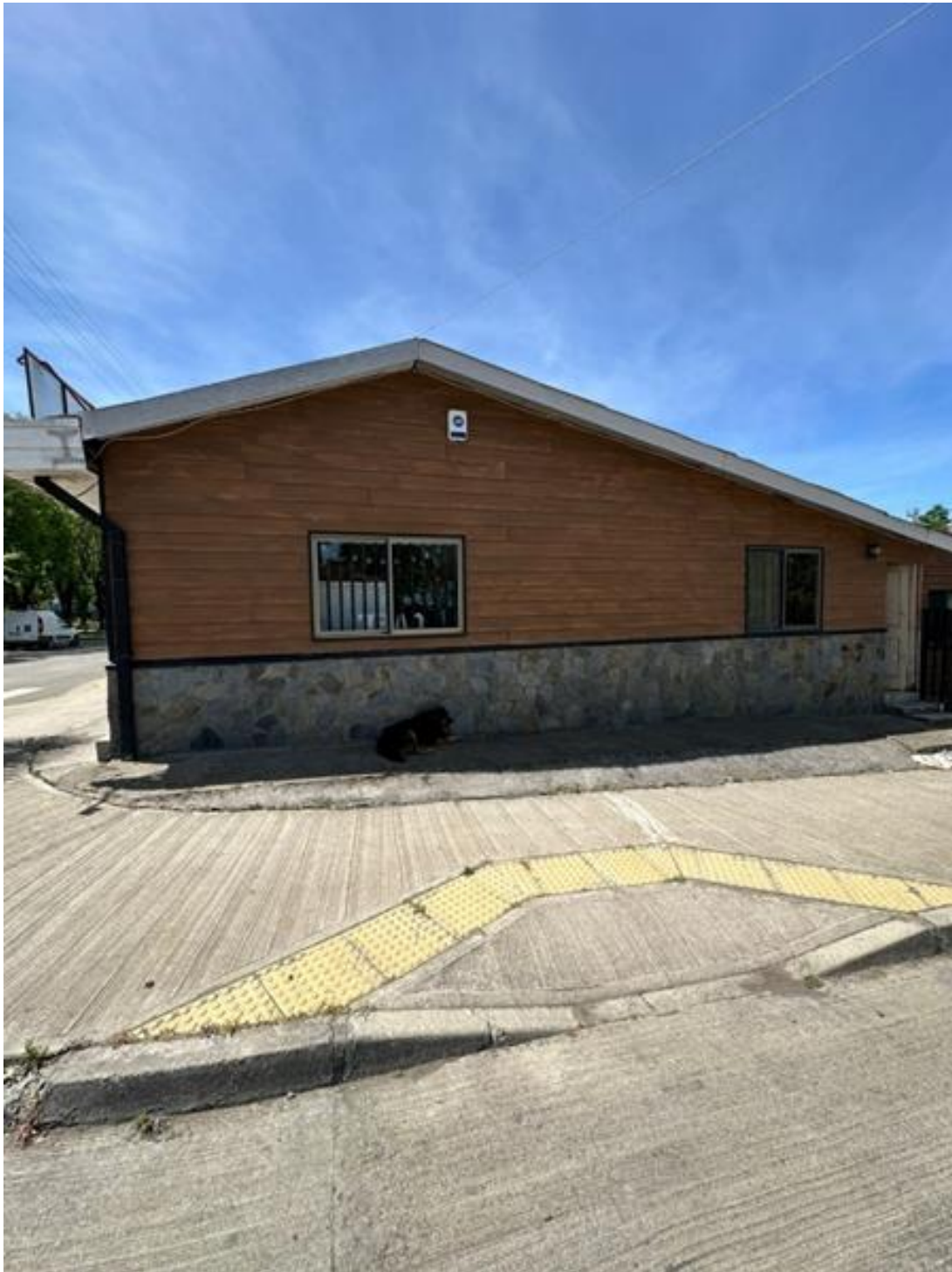
ILUSTRACIÓN 30: VISTA EXTERIOR DE REVESTIMIENTOS COSTADO DEL RESTAURANTE
