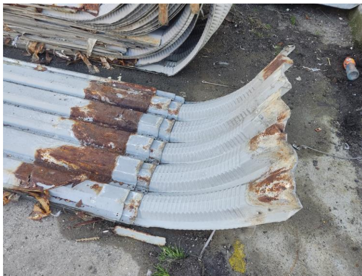
Imagen 7. Plancha de cubierta tipo PV6, retirada por deterioro.
