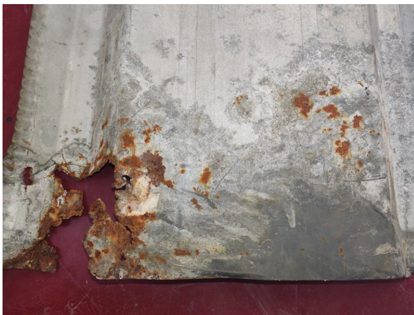
Imagen 4. Parte de una cubierta de tipo industrial retirada por mantención. Superficie expuesta al interior.
