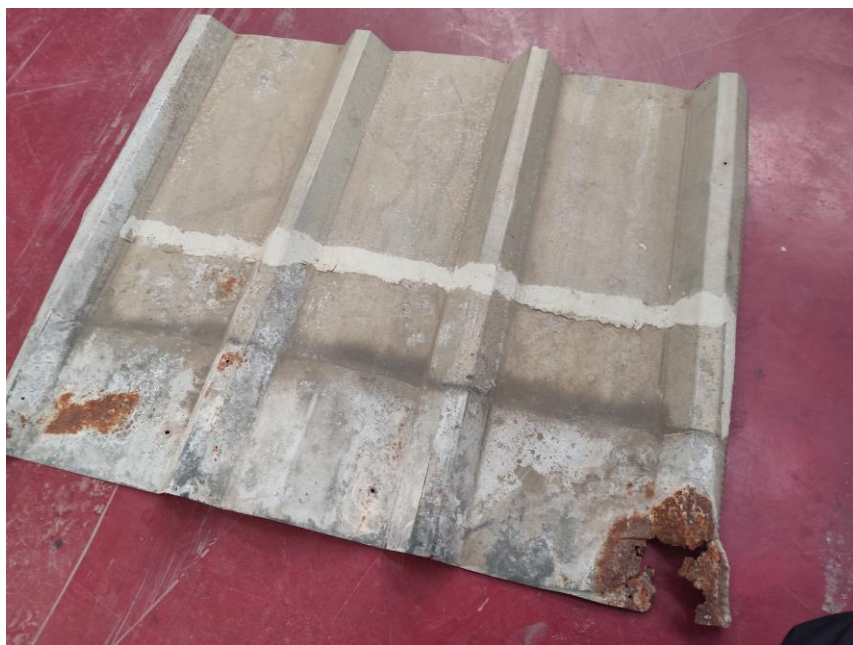
Imagen 3. Parte una cubierta retirada de planta congelados Pesquera Orizon obtenida por mantención. Superficie expuesta al exterior.
