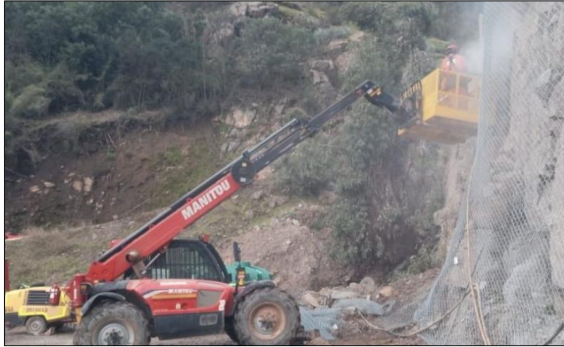
Figura 2-3 Actividad de perforación sobre Manitou
