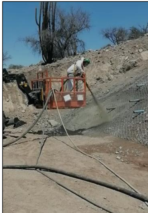
Figura 2-2 Actividad de shotcrete sobre manitou
