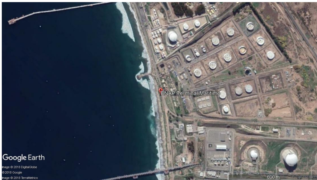
Figura 2. Vista general superior terminal Quintero.
