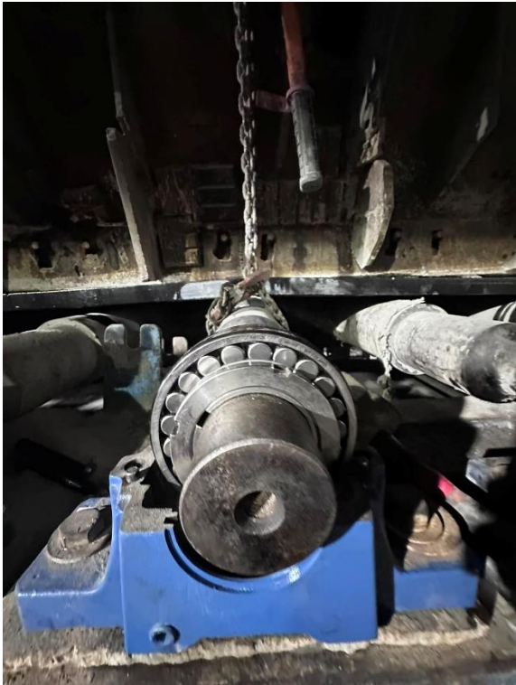
Figura 5. Conjunto eje-rodamiento de un polín polea durante una intervención de mantenimiento en la correa transportadora CM1-A
