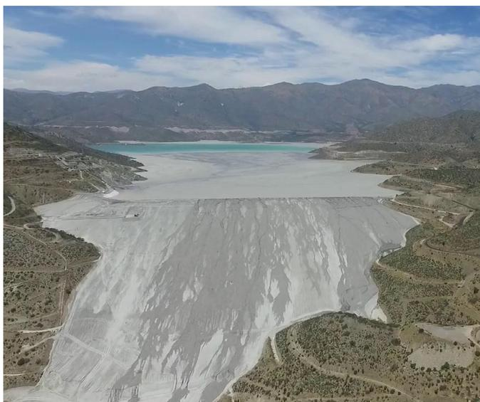
**Figura 5-1: Muro perimetral tranque de relaves, levantado con fracción gruesa obtenida mediante proceso de ciclonaje.**
