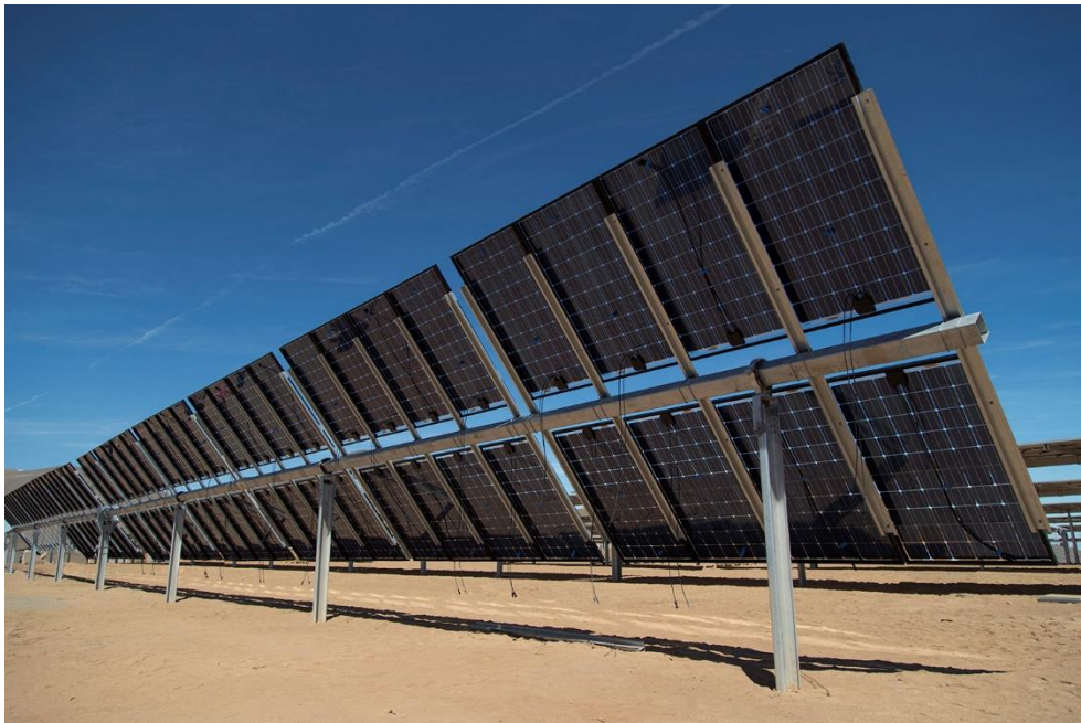
Figura 29: Solar Tracker con módulo bi-faciales (Proveedor de Solar Trackers, s.f.).
