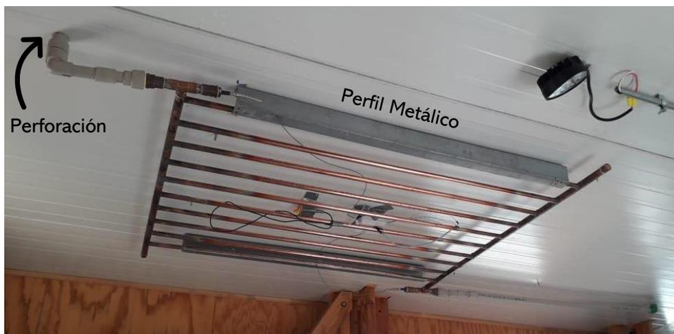
**Figura 24:** Instalación unidad terminal.
