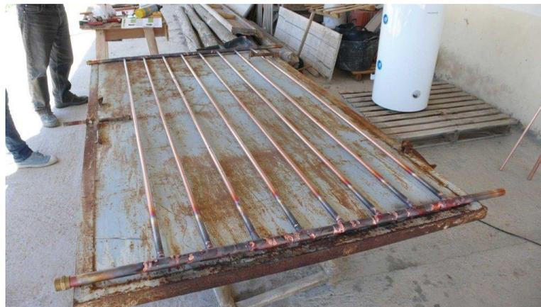
**Figura 15:** Radiador de cobre utilizado como Unidad Terminal del circuito.
