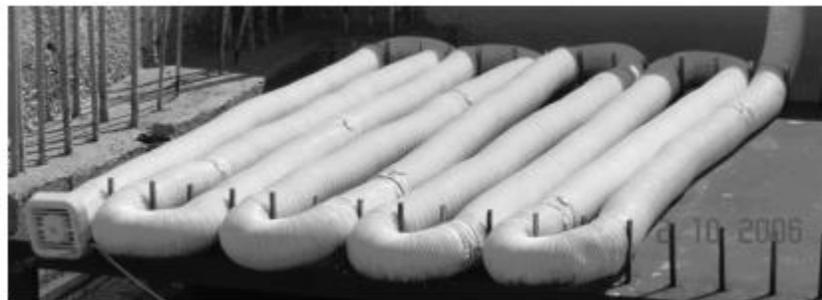
**Figura 4:** Serpentín metálico para enfriar ambientes utilizando aire en Grecia.
