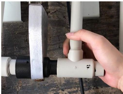
**Figura 23:** Unión tubería PPR mediante fusionadora.
