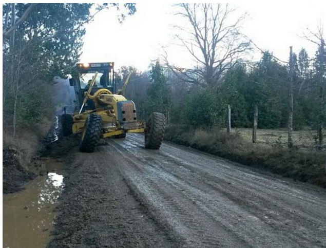
Figura 2-19: Motoniveladora realizando trabajos de reperfilados en caminos rurales de la comuna de Pucón, IX región (fuente: propia).
