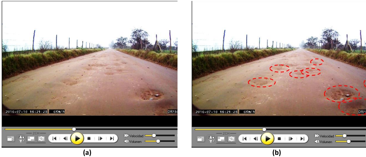
Figura 4-28: “ Baches_{CAM} ” en un camino de tierra, los que se deben identificar y contabilizar dentro de una imagen de video (fuente: propia)
