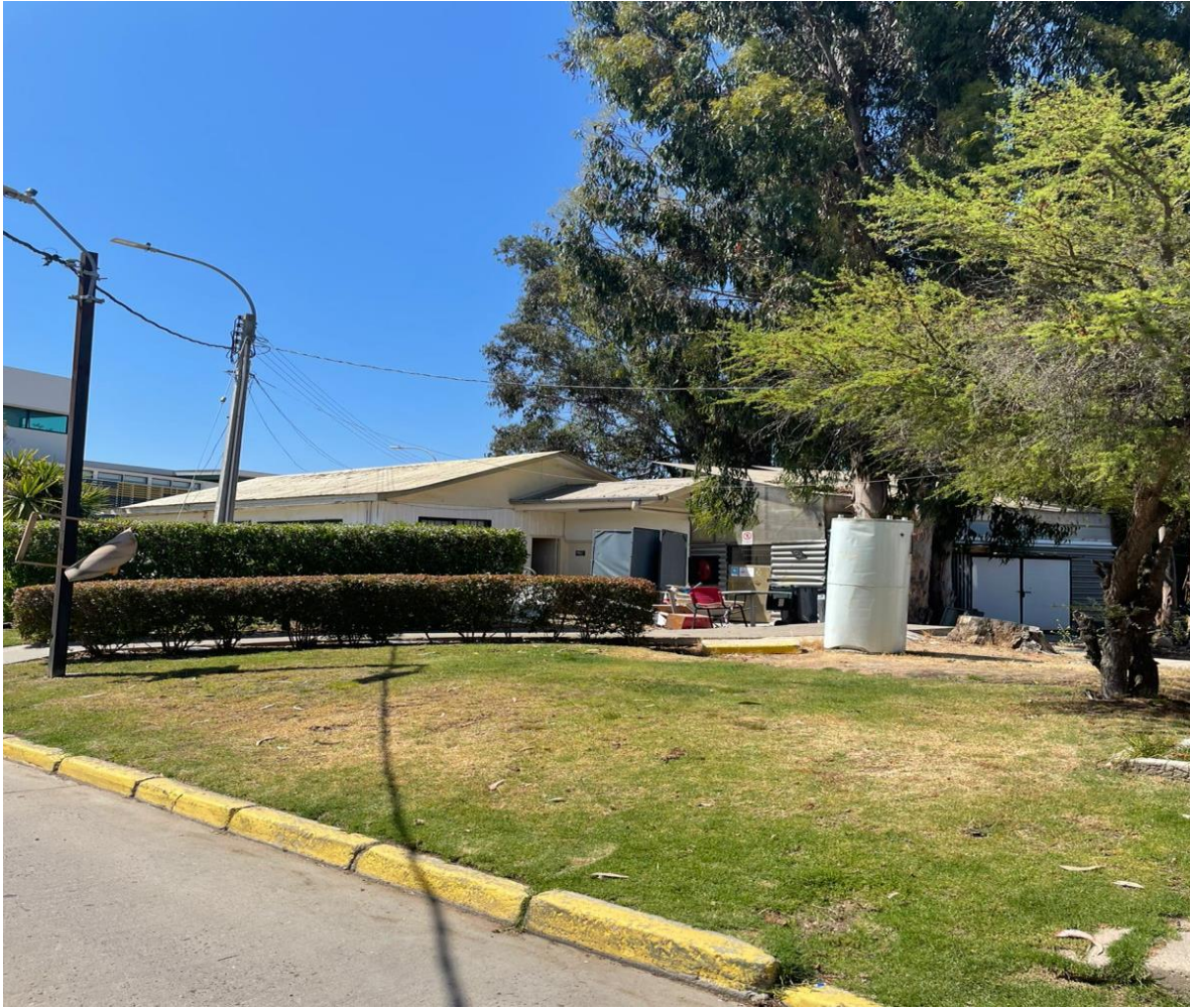
Figura 1.5: Imagen de la ubicación del exterior de la Unidad de Mantenición de la Universidad Técnica Federico Santa María.
