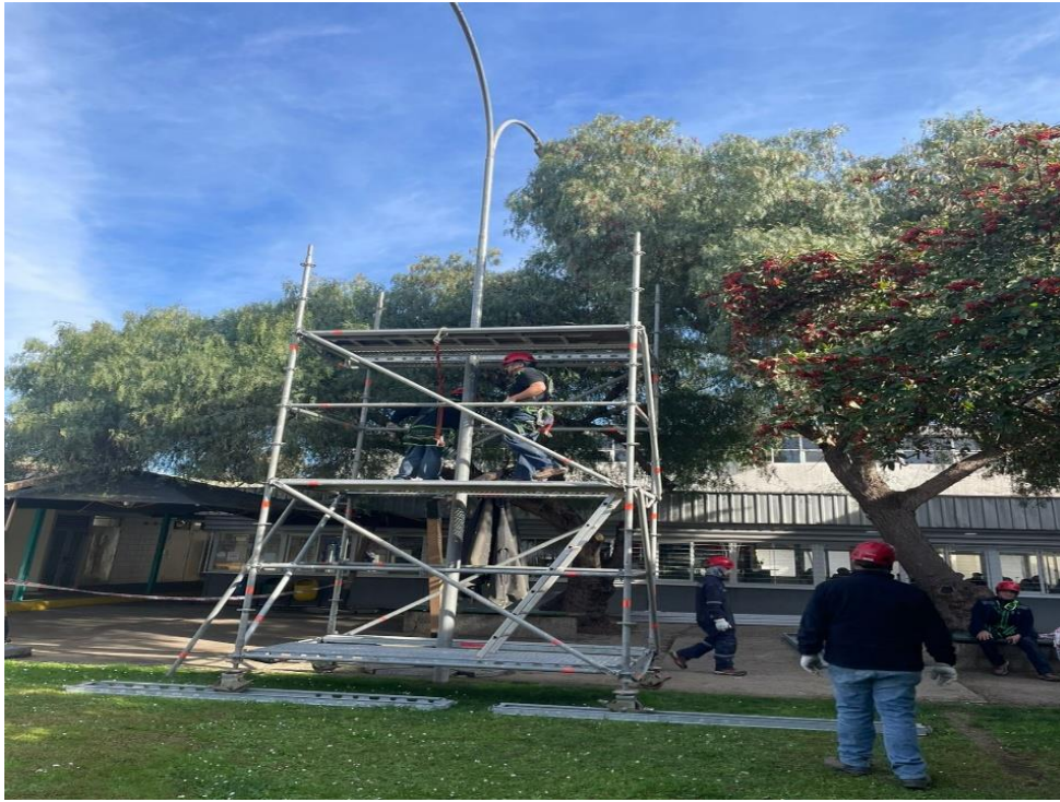
Figura 10.3: Recorrido de inspección, Mantención poste de luz, se solicito todos los puestos de trabajo.
