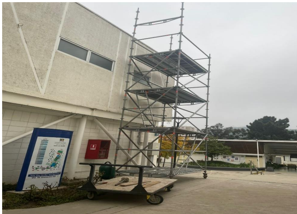
Figura 10.1: Recorrido de inspección, reparación de canaletas aguas lluvias sector gimnasio, puesto de albañilería.
