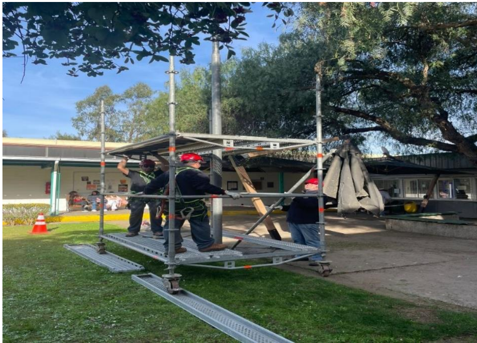
Figura 10.4: Recorrido de inspección, Mantención poste de luz, se solicitó todos los puestos de trabajo.
