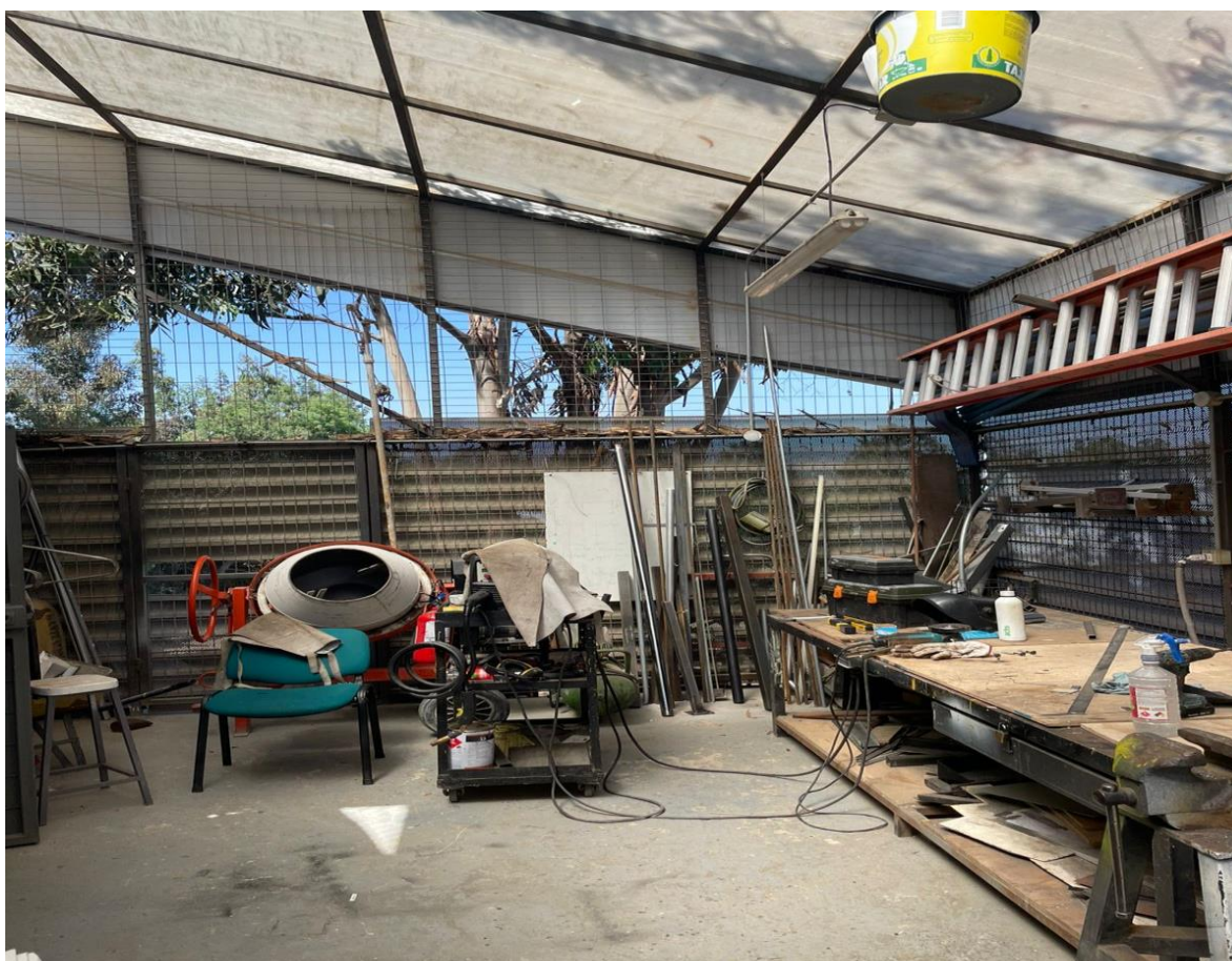
Figura 1.6: Imagen del interior de la Unidad de Mantenimiento, destinado a trabajos de soldadura y a la reparación de piezas y componentes menores.
