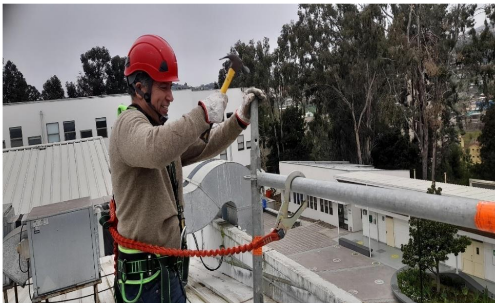
Figura 10.2: Recorrido de inspección, reparación de canaletas aguas lluvias sector gimnasio, puesto de albañilería.
