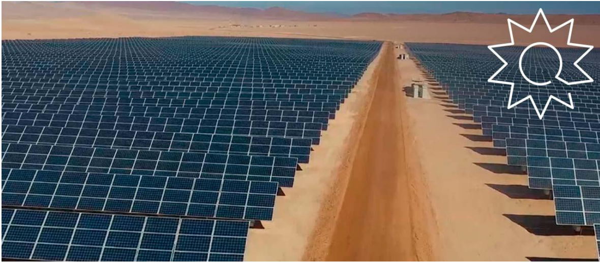
Figura N°2: Planta Solar Pampa Solar Norte. Ubicada en la comuna de Taltal, en la Región de Antofagasta.
