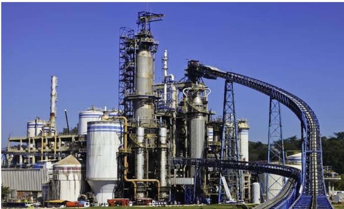
Figura 9: Digestor continuo de fábrica de celulosa junto a impregnadores de vapor, difusor y estanques de acumulación de pasta. Fuente: STI papeles.
