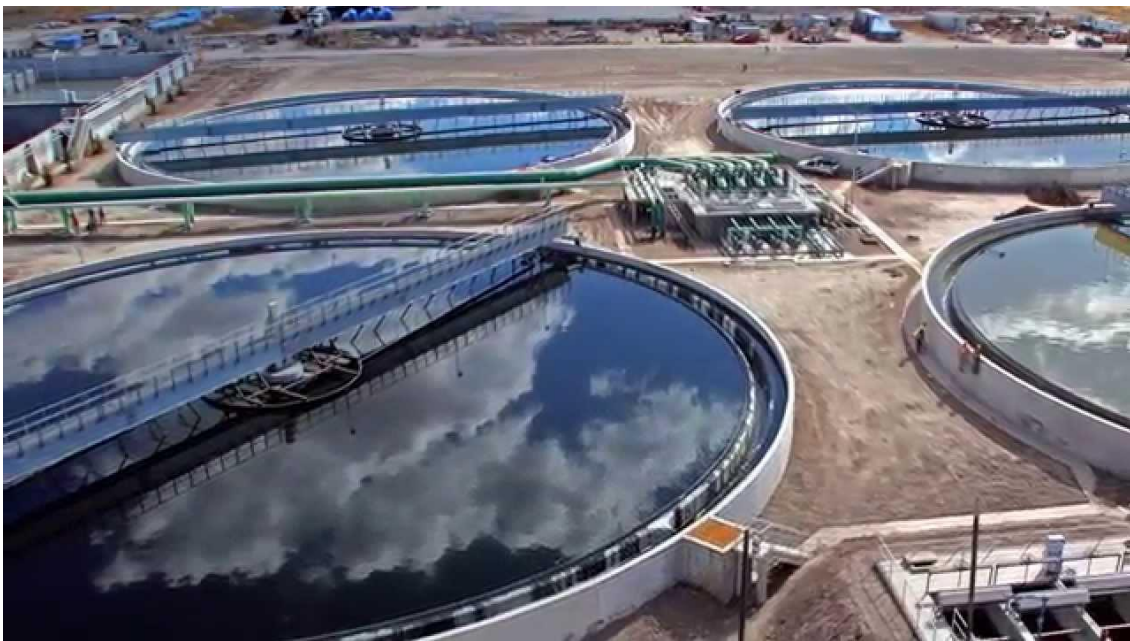
Figura 13: Piscinas de decantado utilizadas en los sistemas de tratamiento de aguas residuales.
