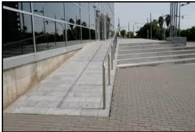
Ilustración 22: Rampa y escalera
