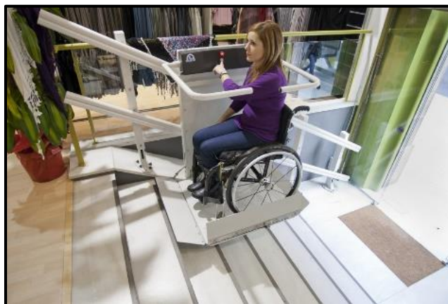
Ilustración 26: Plataforma salva-escalera en funcionamiento
