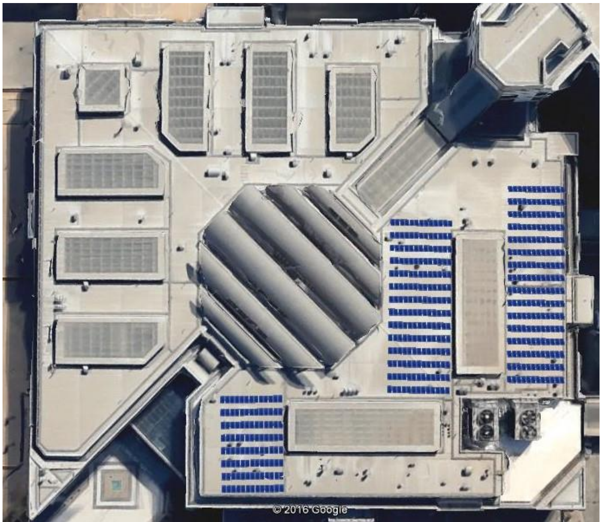
Figura 17: Disposición paneles fotovoltaicos en cubierta Edificio A. (Fuente: Google Earth y elaboración propia)
