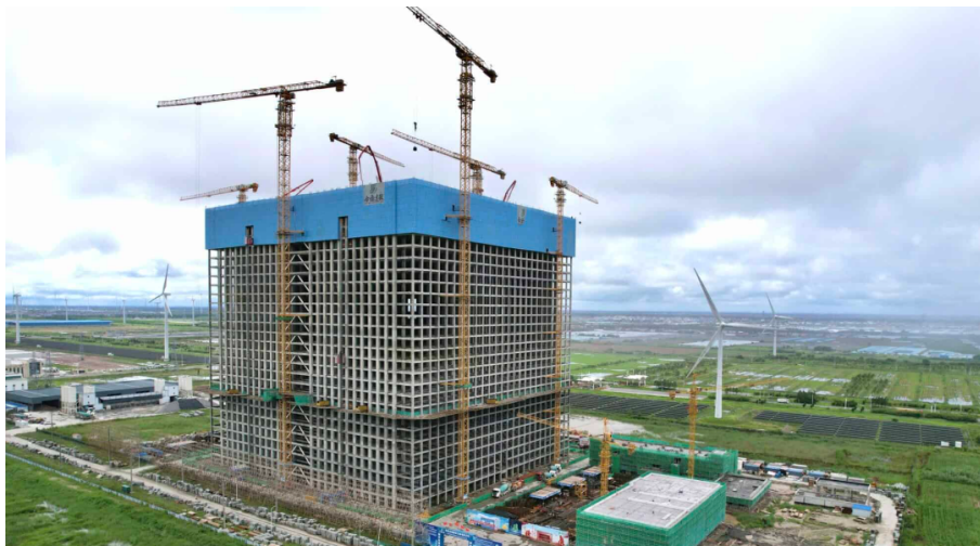
Figura 2.5: Etapa de construcción del proyecto EVx™ de Energy Vault en Rudong, China [5].
