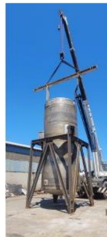
Verificación y detallamiento de elementos de izaje y estructura Cliente: Oxiquim
