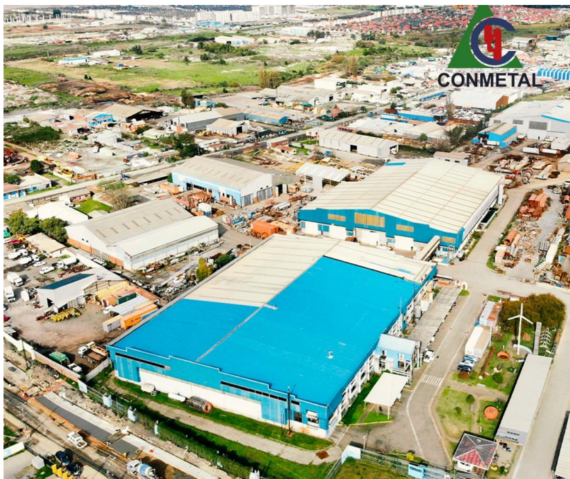
Figura N° 3: Vista aérea de la planta: Monseñor Alarcón 444 - Talcahuano
