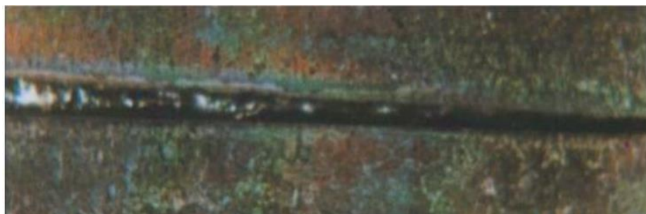
Figura.1.12: Falta de penetración.
