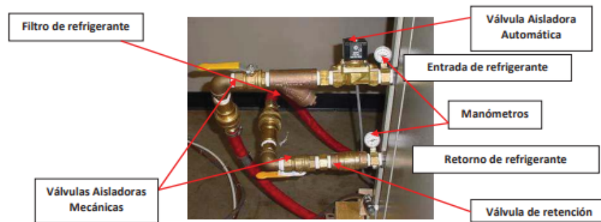
Figura 56- Opción Válvula Aisladora de Refrigerante Instalada
