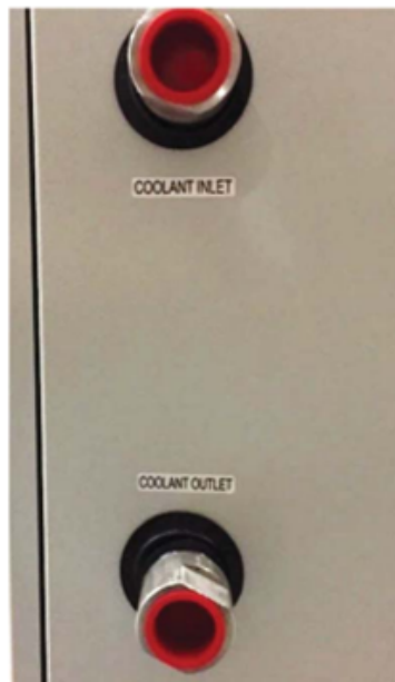
Figura 28- Interconexiones del Agua de Enfriamiento
