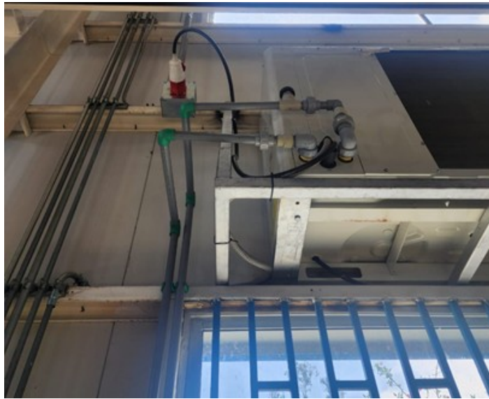
Figura 5.9: Vista de la bomba de calor ya posicionada, donde se observa la modificación en la orientación del codo de entrada del refrigerante, la línea de PPR y el cableado eléctrico con canalización EMT.
