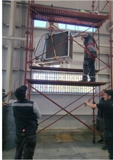
Figura 5.7: Imagen de procedimiento de izaje en altura de bomba de calor
