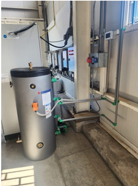
Figura 5.10: Instalación finalizada del estanque y canalización eléctrica del sistema de refrigeración, incluyendo conexiones con tubo flexible, canalización EMT, caja metálica y termostato.
