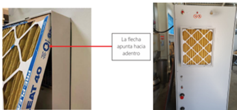
Figura 2.3: Imagen de colocación de filtros de aire y de filtro reinstalado.
