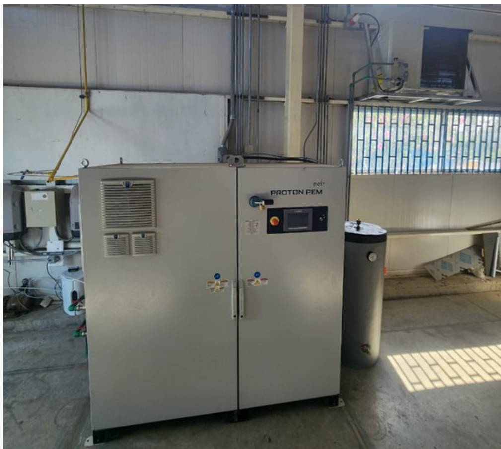
Figura 5.15: Imagen final de la instalación del sistema de refrigeración luego de las verificaciones de su correcto funcionamiento.
