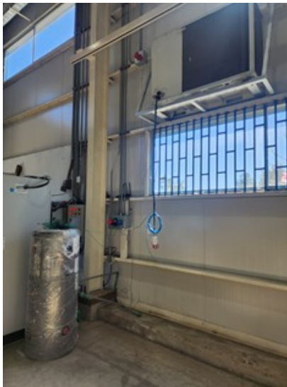
Figura 5.8: Imagen final del posicionamiento de la bomba de calor en la estructura en “L”.
