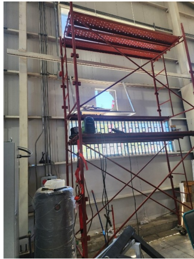
Figura 5.6: Imagen de andamios, fijación de estructura en L y proceso de instalación de rejilla de extracción.
