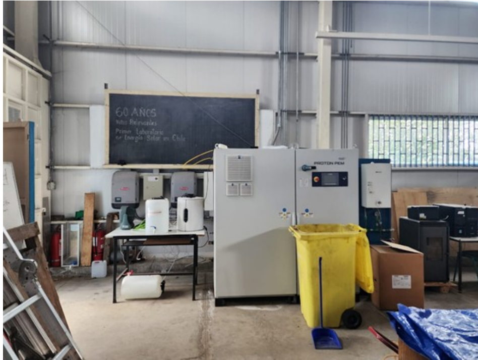
Figura 5.1: Situación inicial sector electrolizador al iniciar la instalación de sistema de refrigeración.
