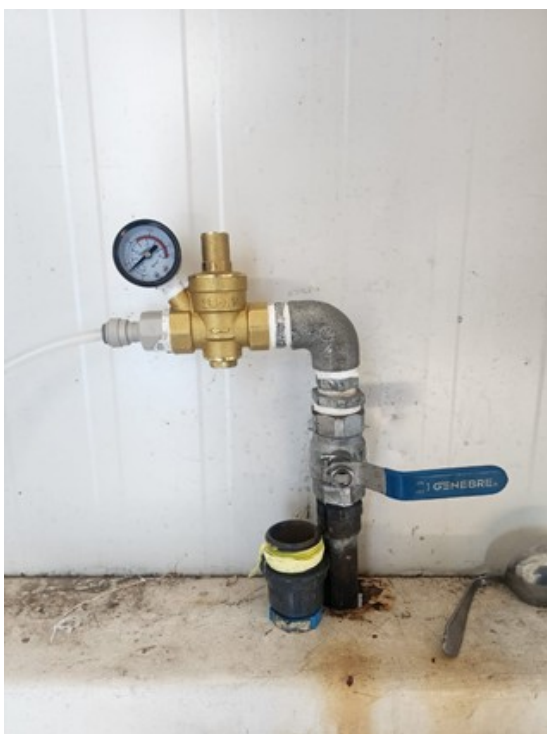
Figura 5.11: Imagen de instalación de válvula reguladora de presión para purificador de agua
