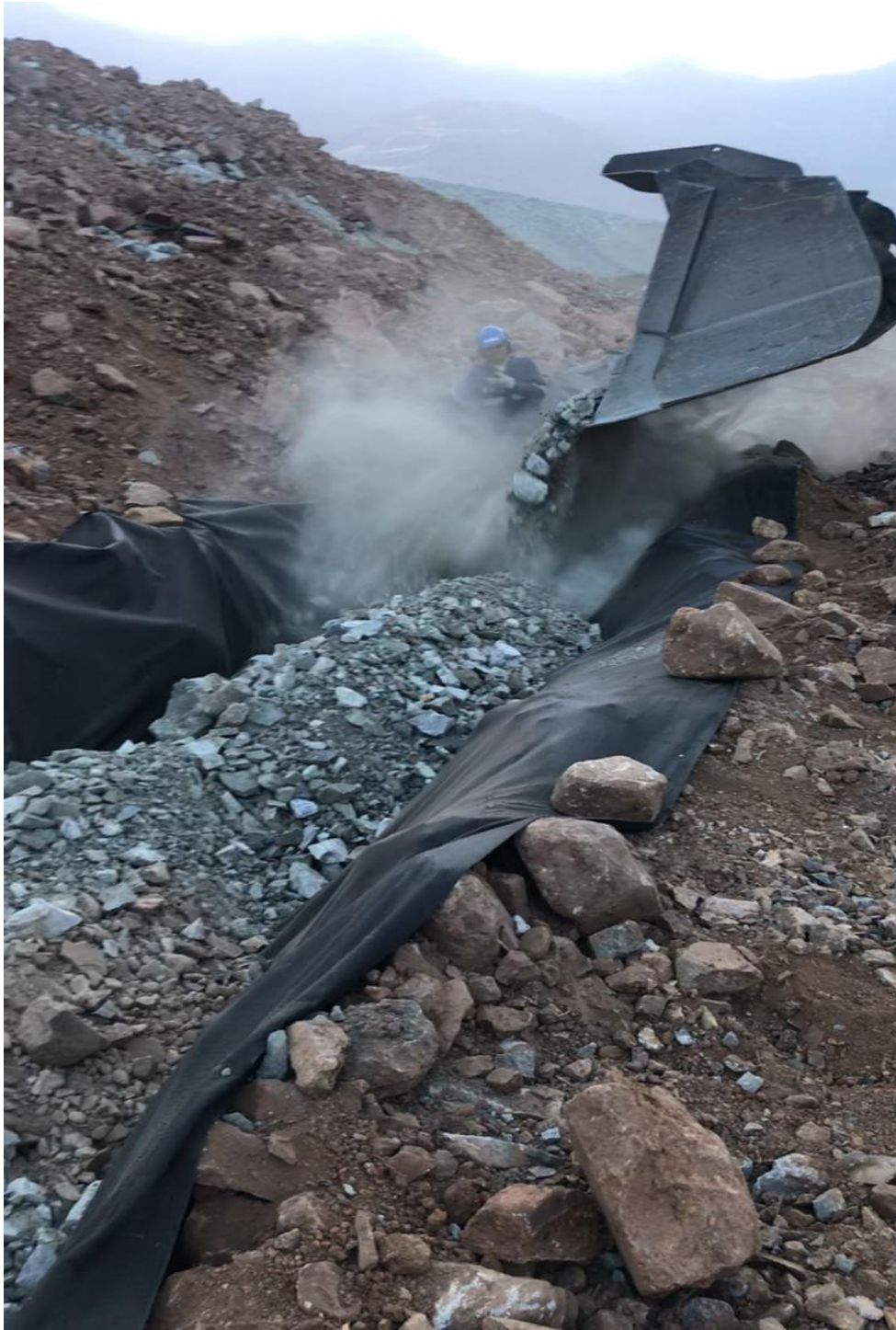
Figura 2-4 Relleno de Excavación
