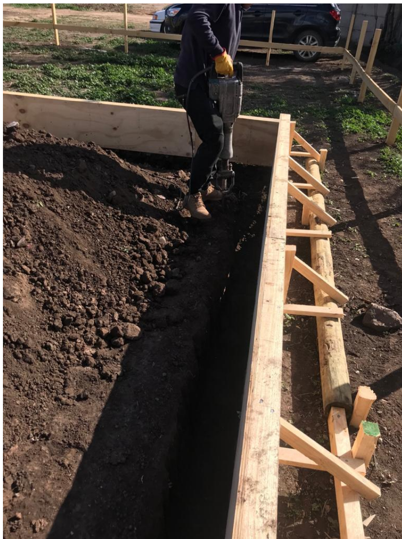
Figura 2-11 Excavación con un roto martillo
