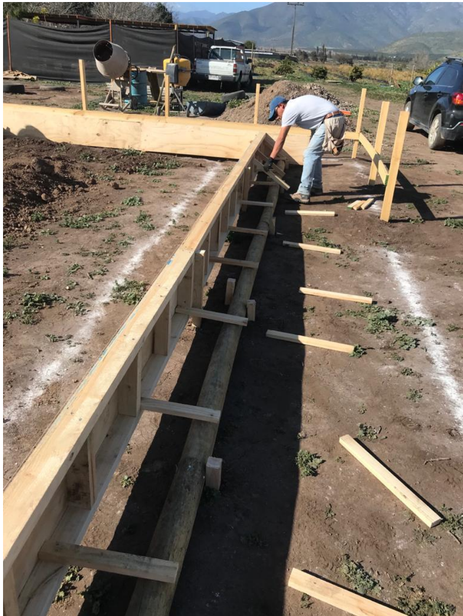
Figura 2-9 Colocación de estacas por durmientes.
