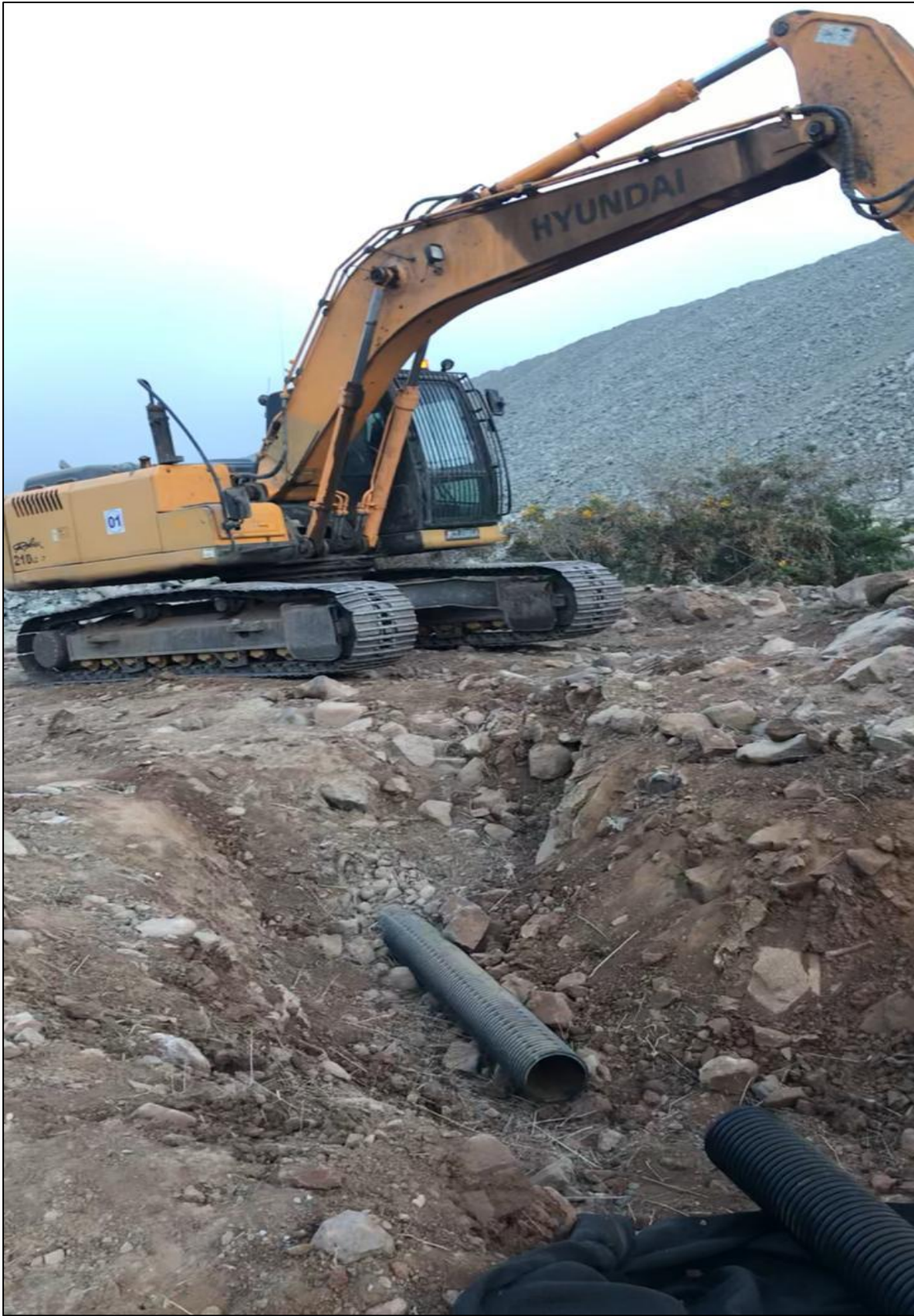
Figura 2-1 Uso de maquinaria para la excavación
