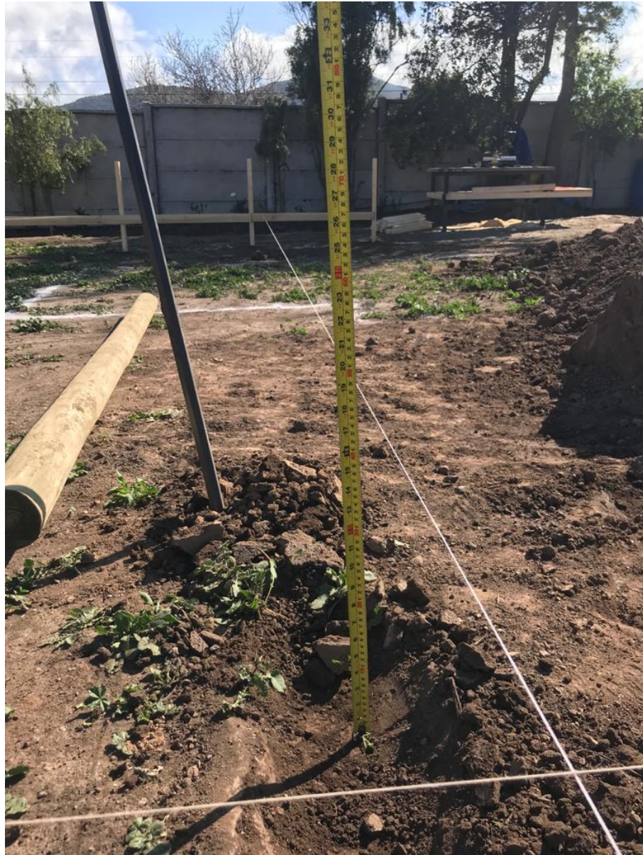
Figura 2-7 Nivelación del terreno
