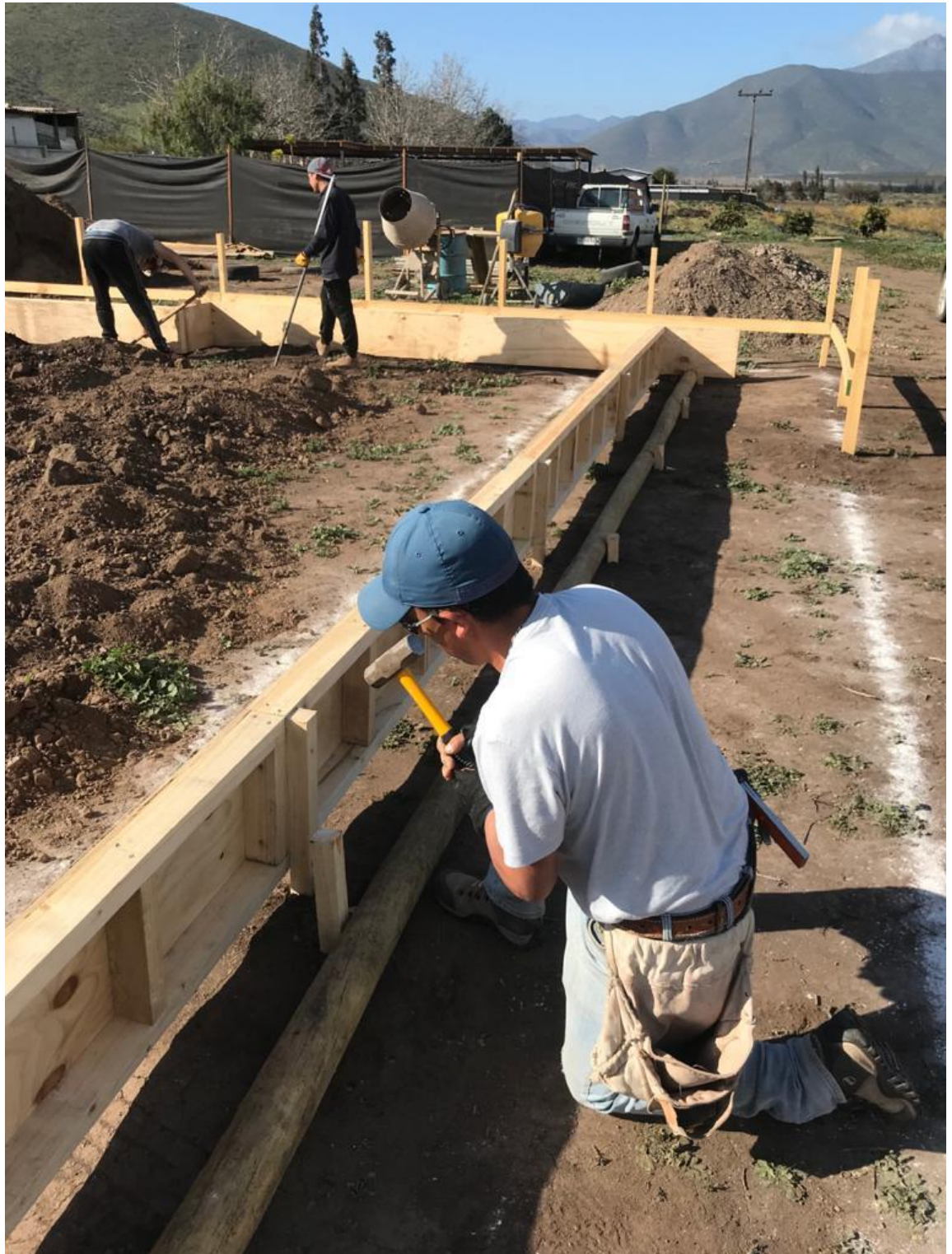
Figura 2-8 Postura de moldaje
