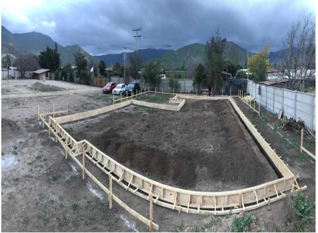
Figura 2-10 Moldaje completo
