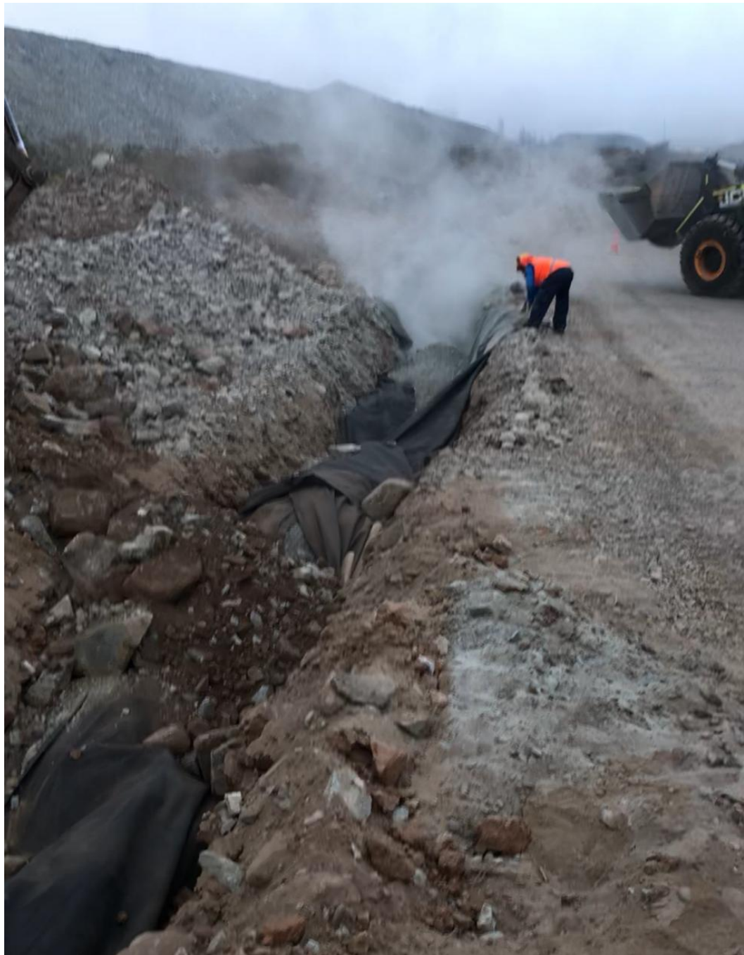
Figura 2-3 Sellado de Geotextil
