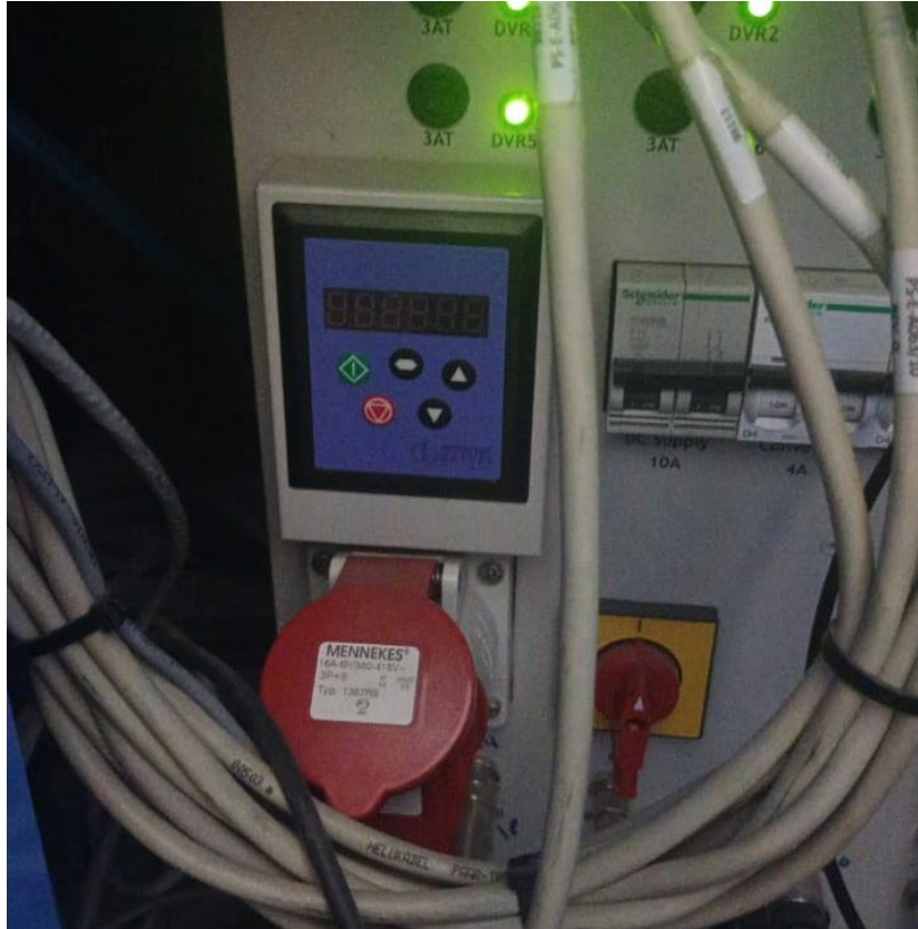
Figura 3-6 Variador de frecuencia
