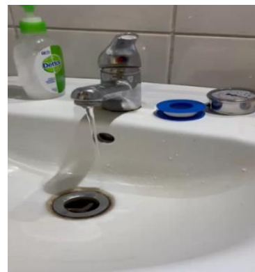
Fig. 1.1 Evidencia de bajo caudal (0,3 L/min).
