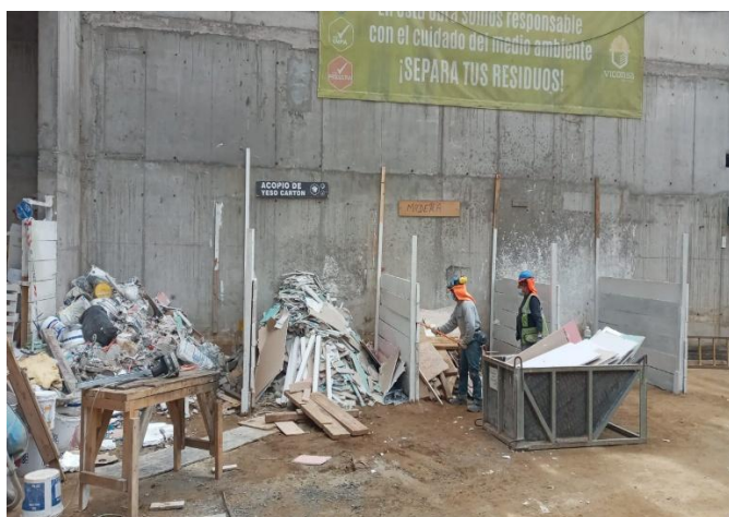
Ilustración 14: Segregación de residuos en obra. Fuente: www.iconstruccion.cl
