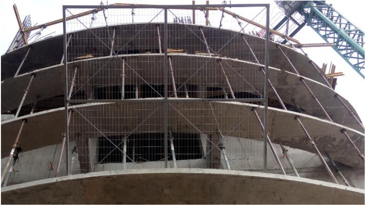
Figura 2-20. Montaje de pantalla
