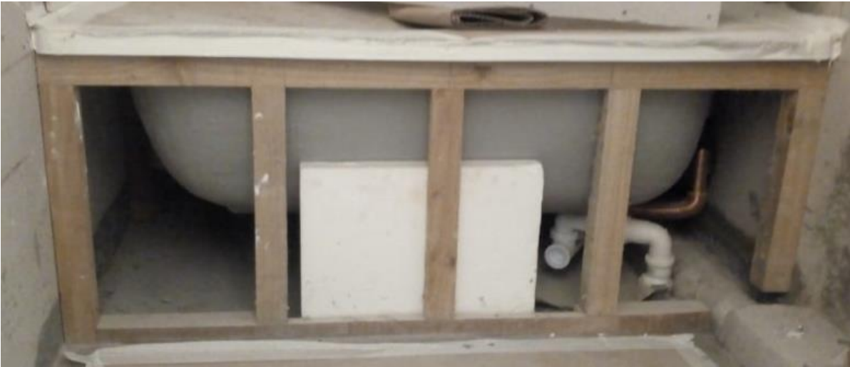
Figura 2-18. Estructura encatrado tina
