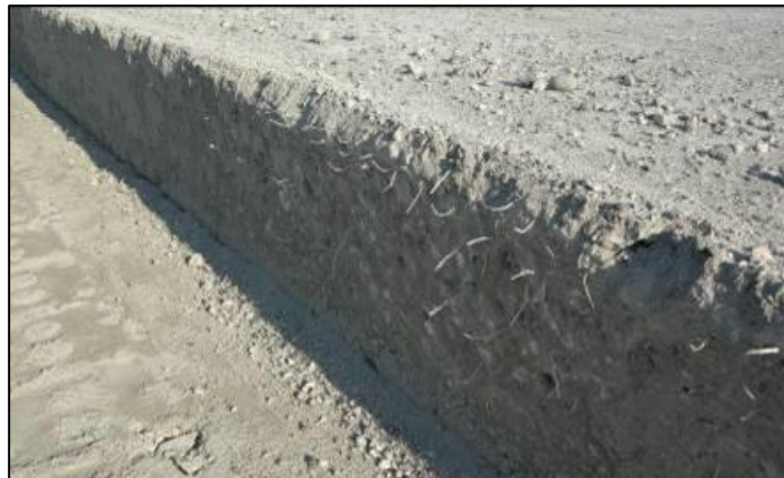
Ilustración N°2: Pavimento con fibras ( Nicieza & Taverna Hnos, Argentina )
