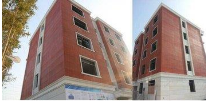
Imagen 7 – Edificio de la provincia de Jiangsu, China. Las paredes de estos edificios son impresas en 3D.
