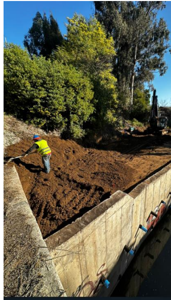
Imagen 31: Relleno estructural y compactación. Fuente: Elaboración propia visita a terreno.
