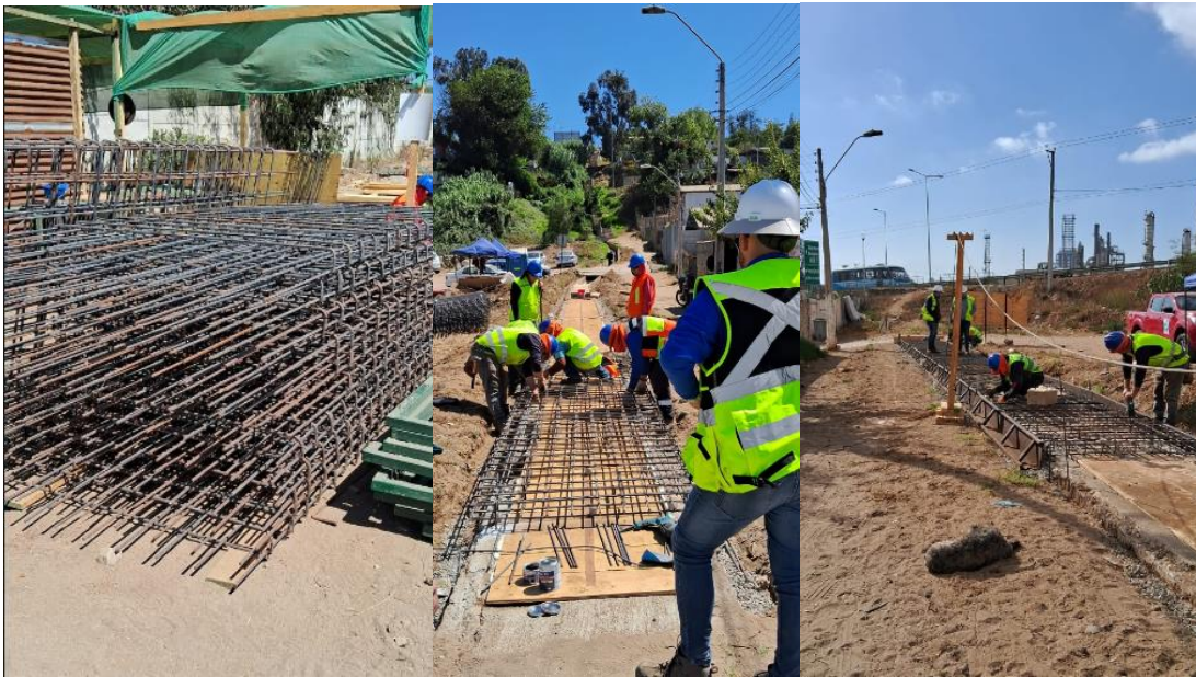
Imagen 18: Armado e instalación de mallas.
