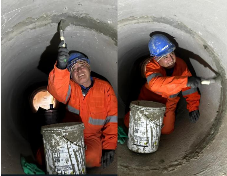
Imagen 37: Tratamiento de fisuras y juntas en colectores.
