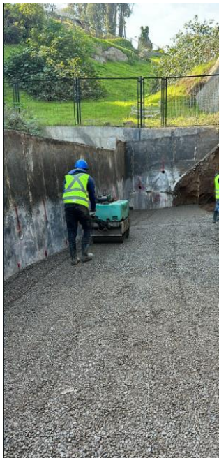
Imagen 28: Excavación para drenaje. Fuente: Elaboración propia visita a terreno.
