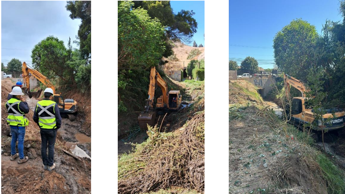
Imagen 27: Actividad de re-perfilamiento de quebrada. Fuente: Elaboración propia Supervisión frente de trabajo.
