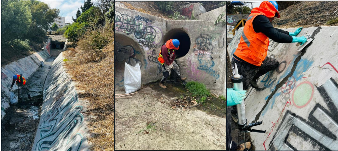
Imagen 24: Limpieza de canal, reparación de fisuras y sello de juntas.
