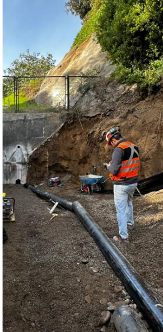
Imagen 30: Instalación de dren y barbacanas. Fuente: Elaboración propia visita a terreno.
