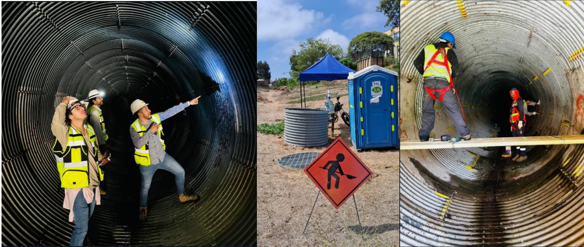
Imagen 25: Identificación, implementación de condiciones, ejecución del apriete de tuercas y sello de perforaciones.
