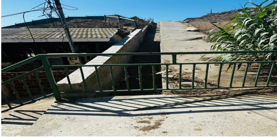
Imagen 35: Peralta miento de muro e impermeabilización.
