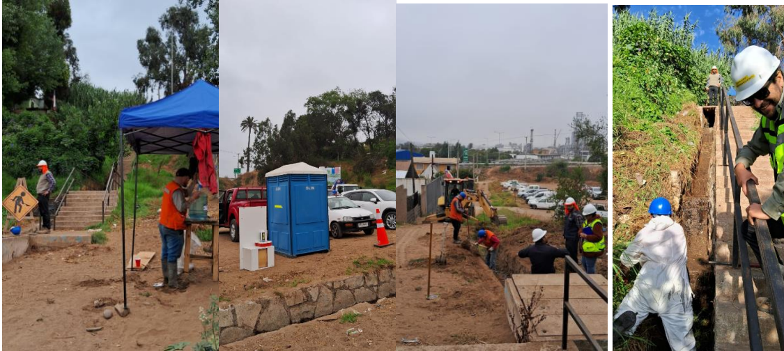
Imagen 17: Instalación de baños químicos.
