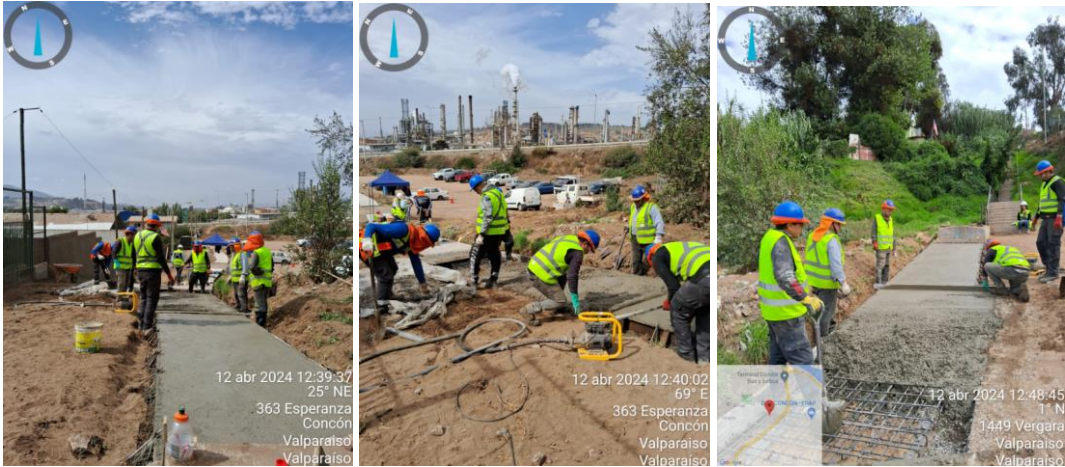
Imagen 19 y 20: Hormigonado de canal Vergara.
