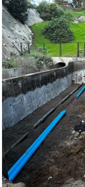
Imagen 30: Instalación de dren y barbacanas. Fuente: Elaboración propia visita a terreno.
