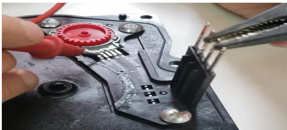
Imagen 3-18: inspección de circuito de actuador
