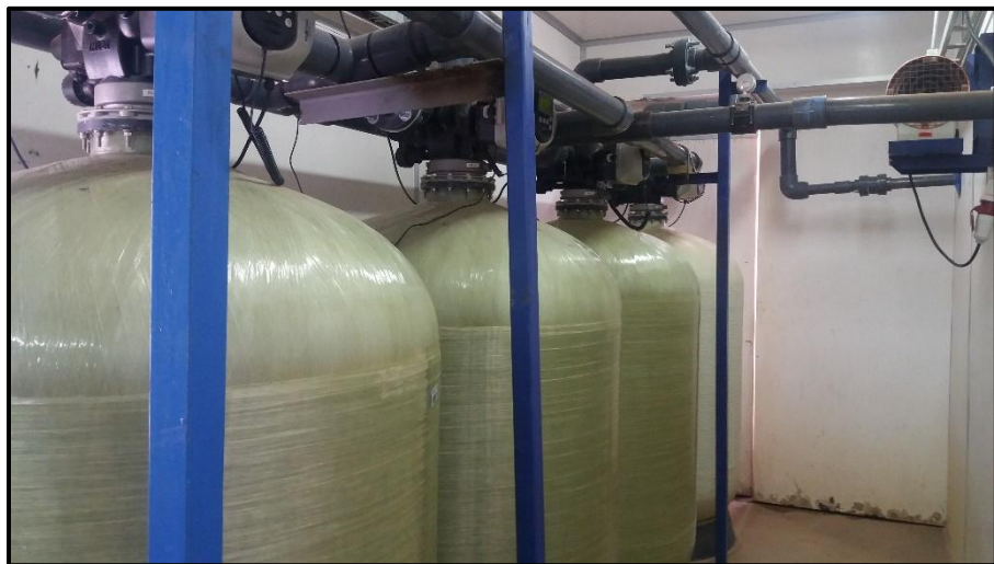
Figura 1-9: Registro fotográfico de los filtros de carbón y multivía tricapa
