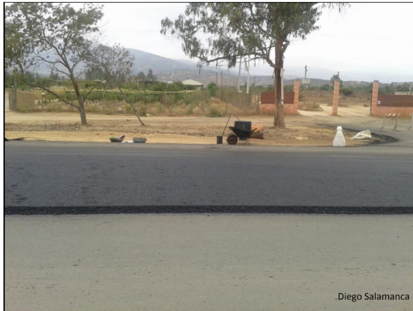
Figura 2-6: Carpeta asfáltica tras proceso de compactación
