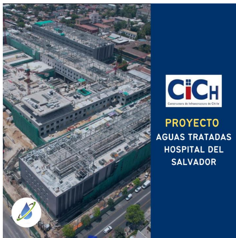
FIGURA 1-1 CONSTRUCCIÓN HOSPITAL EL SALVADOR PROVIDENCIA, FUENTE (LINKEDIN, 2023)
