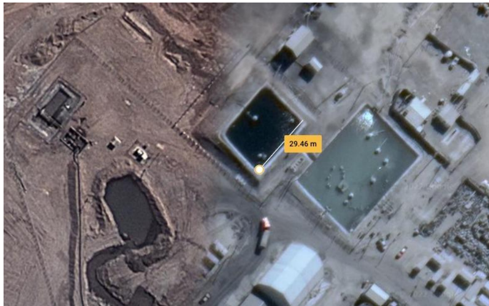
Figura 15: Piscinas de abastecimiento hídrico de la Faena Taltal
