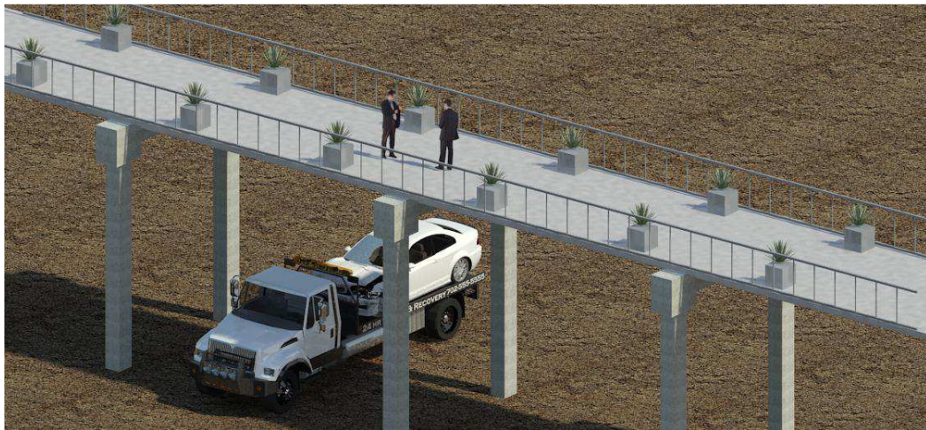
Figura 6.70. Pasarela peatonal, estructura industrial de pórticos de hormigón armado.
