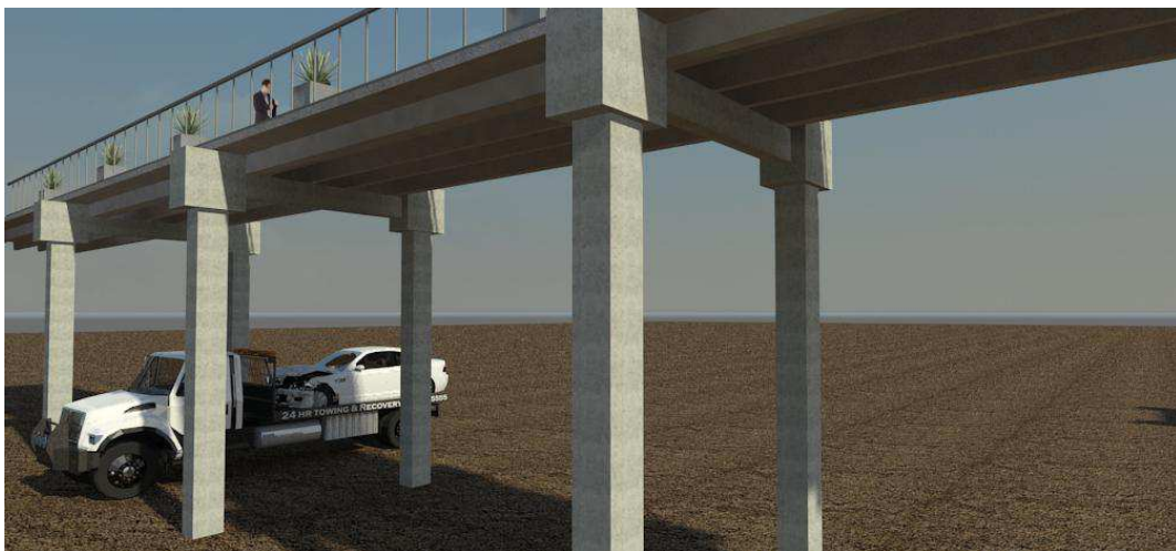
Figura 6.71. Pasarela peatonal, estructura industrial de pórticos de hormigón armado.
