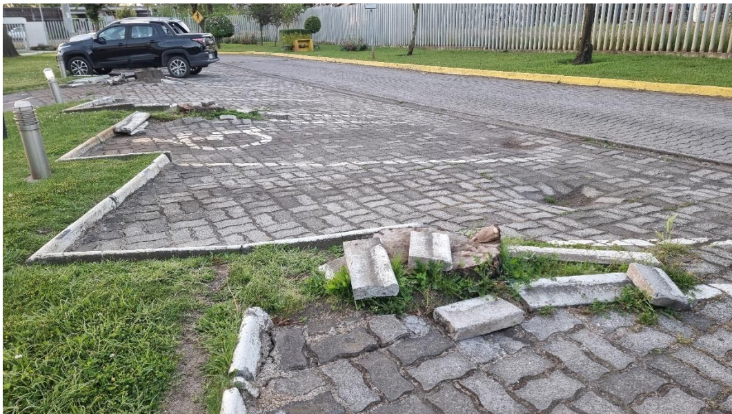
Ilustración 39 – Registro fotográfico Solerillas. Fuente: Elaboración Propia.
