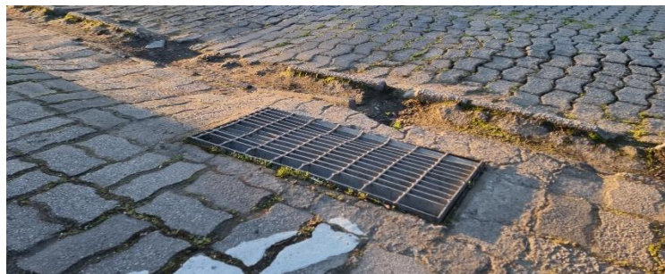
Ilustración 12 – Fotografía Sumidero existente. Fuente: Elaboración propia.
