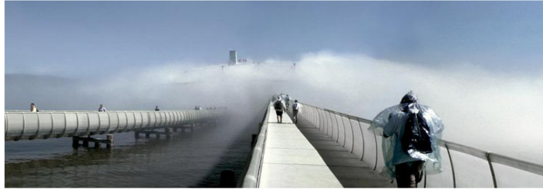
Fig. 16. Doble pasarela, Fuente: (Beat Widmer, Viva, 2020)
