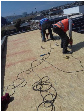
FUENTE: Tomada de terreno
