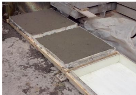
Foto N° 4: Vaciado hormigón en moldajes cuadrados.
