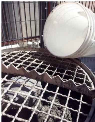
Foto N° 1: Incorporación aditivo polimérico ETONIS 850.
